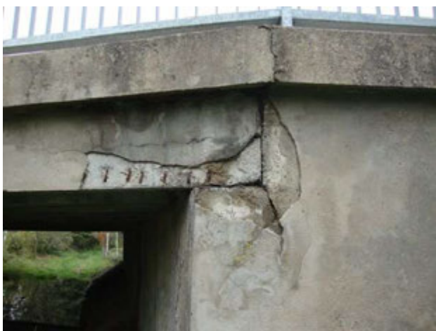
Obr. 15: Detail uložení, trhlina v úložném prahu.
