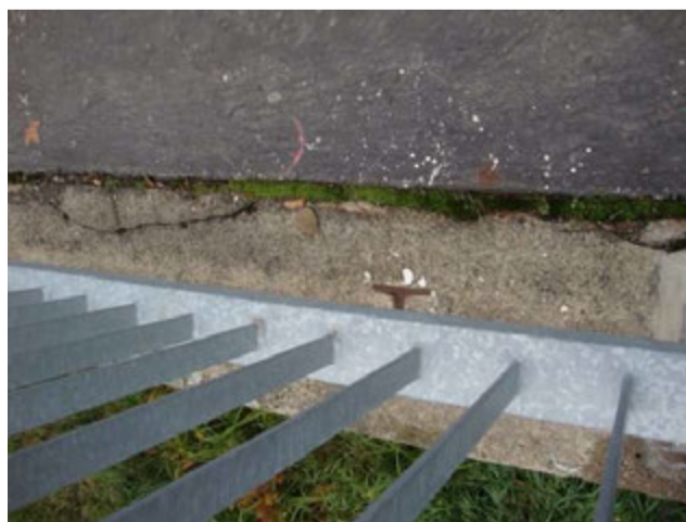
Obr. 2: Chodník s živící s četnými trhlinami.
