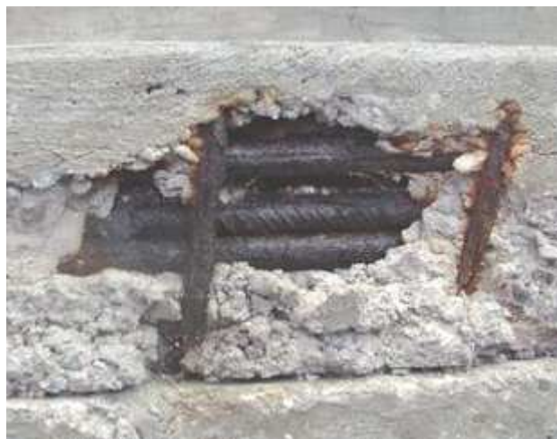
Obr. 16: Koroze dolní stěny prefabrikátu NK.
