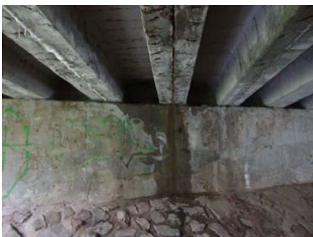
Obr. 17: Výrony vody na opěře.
