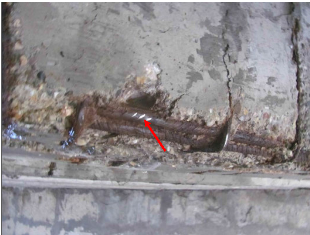
Foto 3: Pohled na sondu k výztuži SV2, spodní líc nosníku. Silná koroze výztuže. Viditelné trhliny v místě třmínků způsobené expanzními korozními tlaky.
