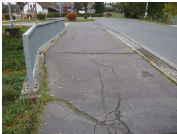
Obr. 2: Chodník s živící s četnými trhlinami.
