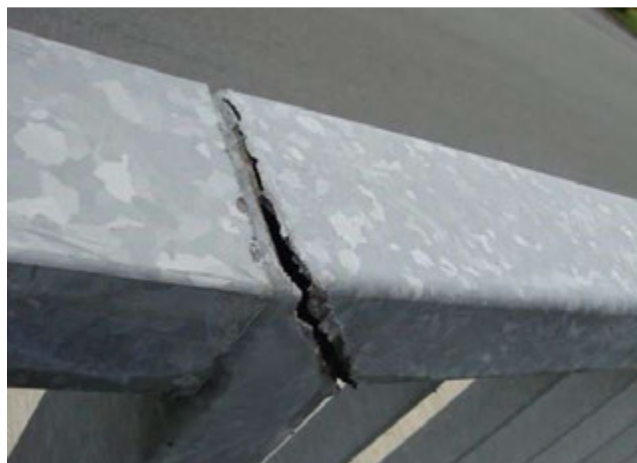
Obr. 8: Trhlina zalitá živičnou zálivkou.
