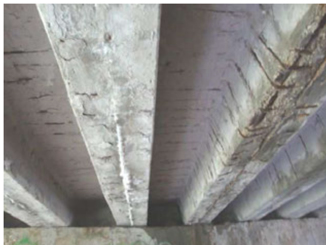
Obr. 14: Zatékání, koroze výztuže, absence krytí.
