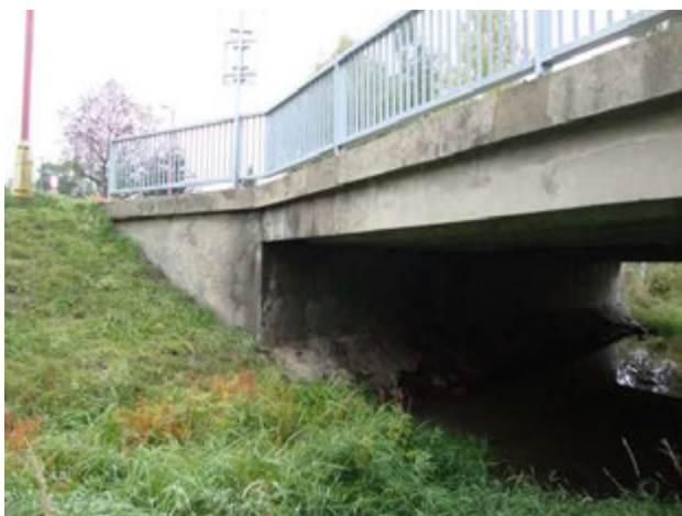
Obr. 13: Levostranná opěra a křídlo.
