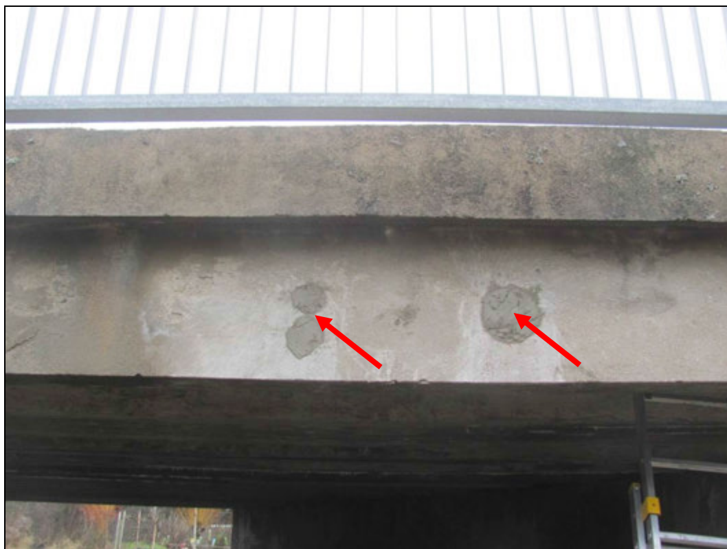
Foto 4: Detail zapravení sond po provedených jádrových vrtech.
