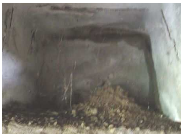
Obr. 18: Sypký materiál vypadává dírou v NK.
