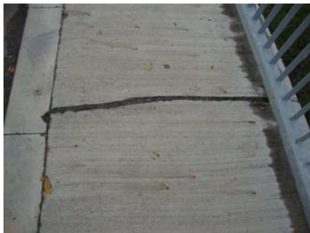
Obr. 8: Trhlina zalitá živičnou zálivkou.
