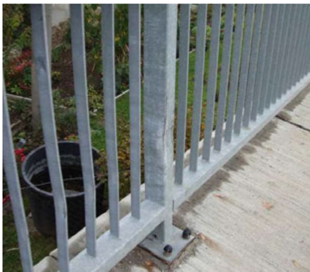
Obr. 9: Nabouraný sloupek zábradlí.
