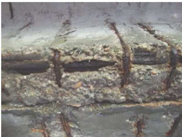
Obr. 15: Koroze dolní stěny prefabrikátu NK.
