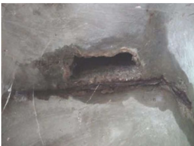
Obr. 17: Díra v horní desce NK, zatékání.
