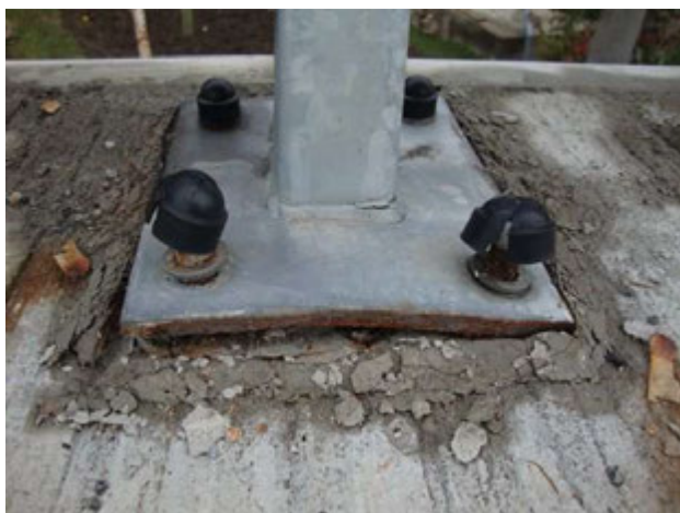
Obr. 11: Poškozené kotvení sloupku zábradlí.
