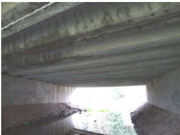
Obr. 13: Zatékání, nedostatečné krytí.
